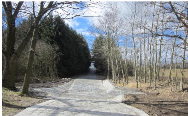
Stav po realizaci
