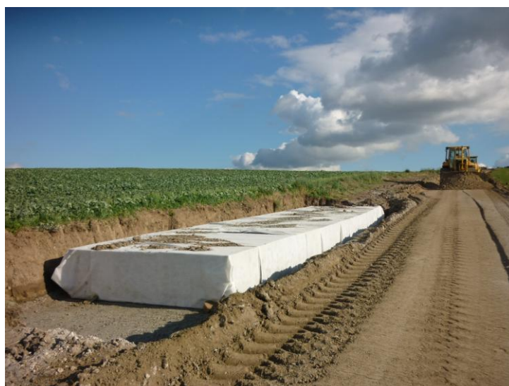
Zpracování technologických vrstev a jáma pro zasakovací jímku
