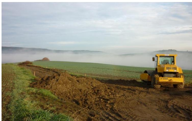
Skrývka ornice a podorničních horizontů v trase cesty
