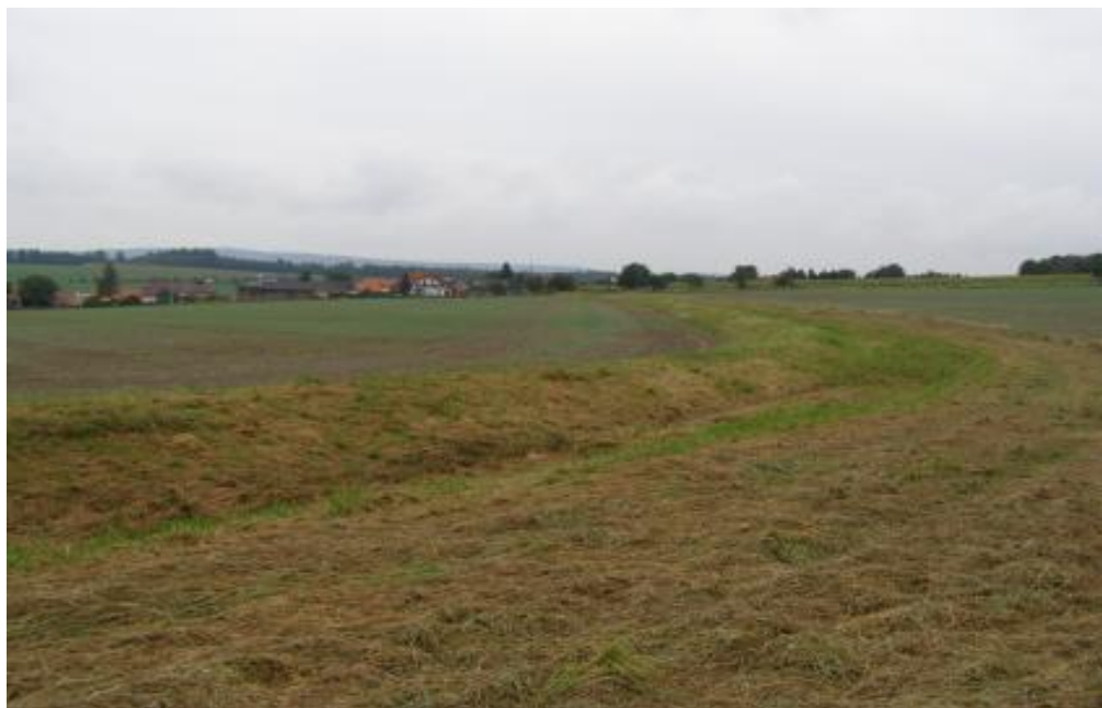
Foto. 1. Milínov – protierozní mez s průlehem nad intravilánem(foto Mazín,2012)
