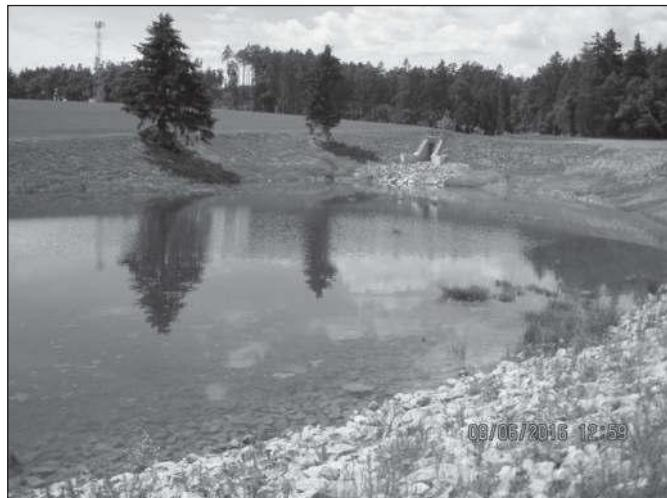
Parametry horní nádrže: zátopová plocha při stálé hladině – 0,1450 ha, objem vody při stálé hladině – 1300 m<sup>3</sup>, maximální retenční objem – 690 m<sup>3</sup>, šířka hráze v koruně – 3,0 m, max. výška hráze – 5,4 m, plocha litorálního pásma – 600 m<sup>2</sup>.
