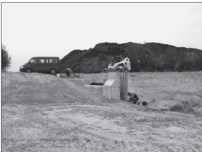
Obr. 17. Výstavba vodní nádrže v k.ú. Choťovice 2007
