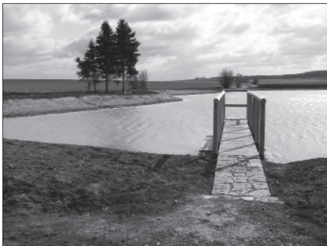
Obr.18. Vodní nádrž po kolaudaci 2008
