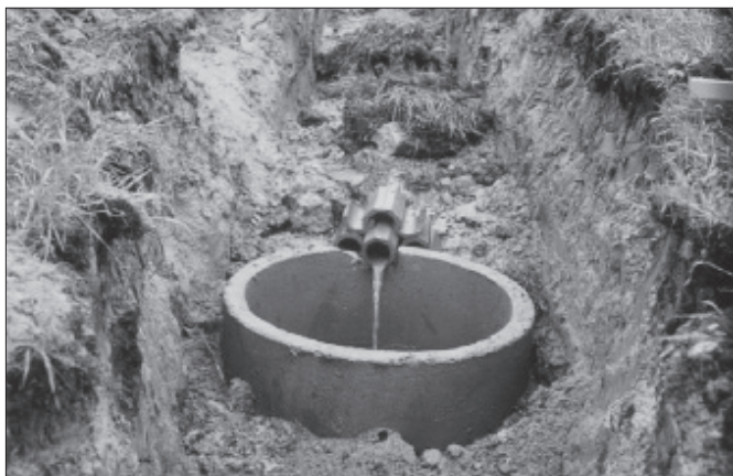
Foto 4: Stálý odtok vody z drenážního systému (zdroj: Kvítek T.)
