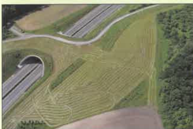
11. Výsadby na zeleném mostě přes D 11 v k.ú. Žehuň
