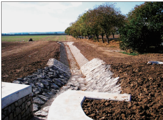
Obr. 9. P 1 – zpevněný začátek obtokového kanálu
