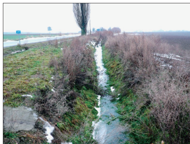
Obr. 7. Původní koryto vodního toku Rojdánka
