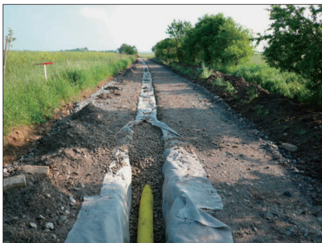
Obr. 5. Vedlejší polní cesta C 14 – umístění drénu v ose
