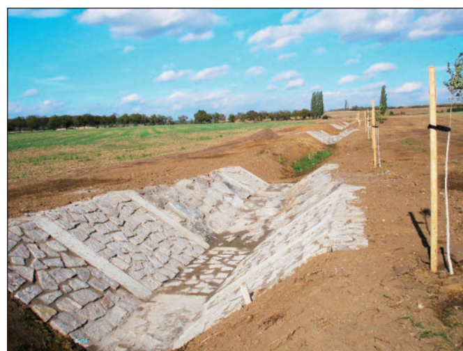
Obr. 8. Obtokový kanál P 1 – kamenitý skluz a doprovodná zeleň
