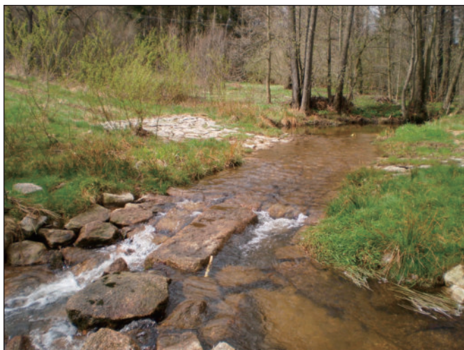
Obr. č. 3 – Brod na polní cestě v rámci revitalizace Holubího potoka (Jizerské hory)
