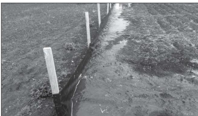
Sedimentační plůtek (silt fence) dokáže účinně směrovat povrchový odtok
