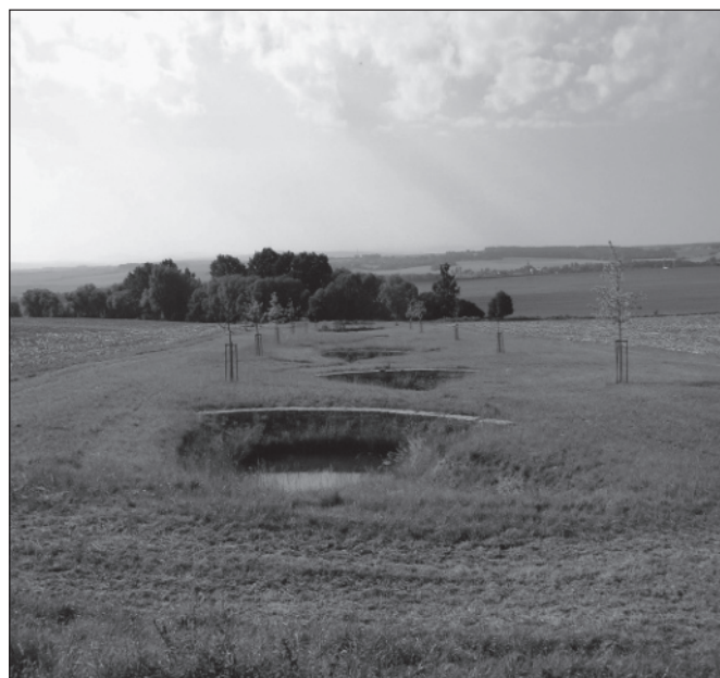
Obr. 4 Vsakovací jámy těsně po realizaci 2014 (foto: archiv KPÚ Pro Plzeňský kraj, Pobočka Plzeň)
