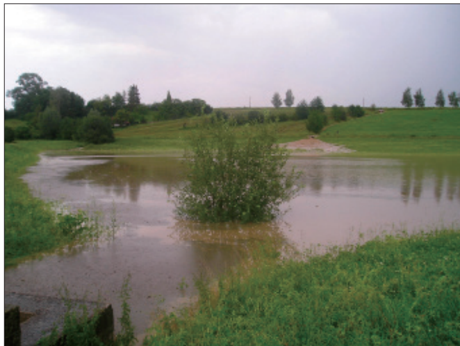
Poldr chránící část zástavby města Litomyšl ve funkčním stavu při povodni 22. 7. 2009
