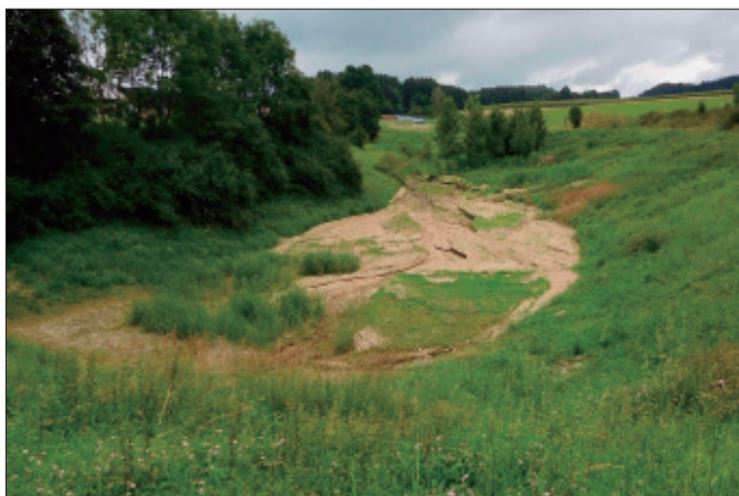
Celkový pohled do zdrže poldru, který je vlivem nevhodně zvoleného protierozního hospodaření zazeměn smyvem ornice.
