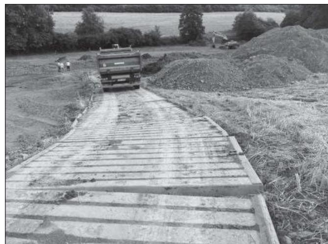
Obr. 9 Přístupová cesta z ocelových desek s dočasným vynětím ze zemědělského půdního fondu na pozemku pana Šilhánka
