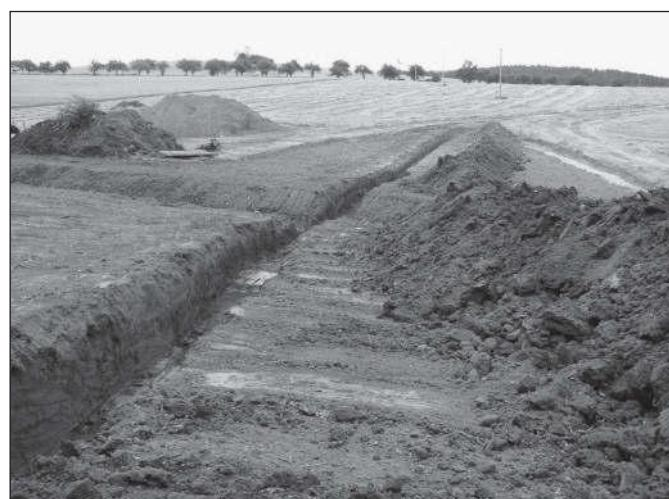
Obr. 10 Výkop pro zavazovací ostruhu hráze a těsnící jádro hráze
