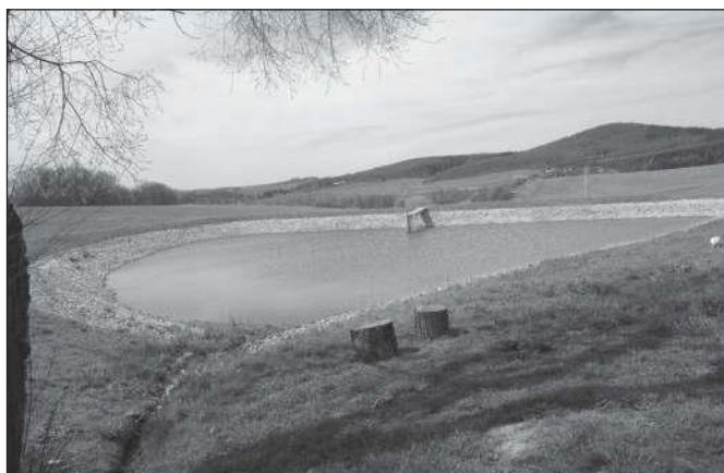
Obr. 14 Jedna ze tří malých vodních nádrží s retenčním prostorem
