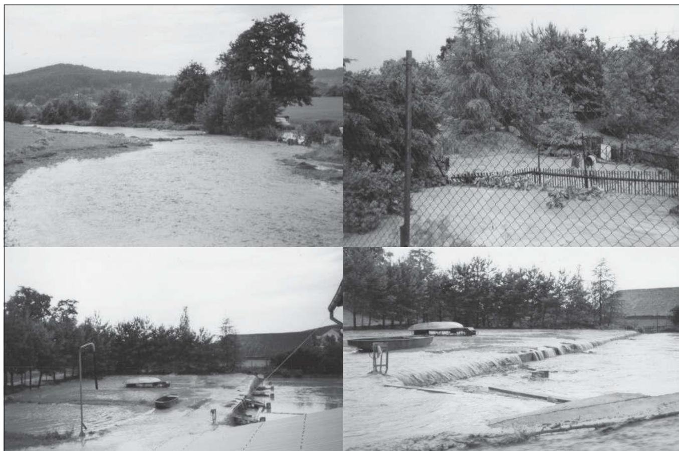
Obr. č 1 Povodňová událost na soutoku Předenického potoka a Úhlavy v roce 2002 v místě hranice zastavěné části obce. Kapacitně nevyhovující koryto toku.
