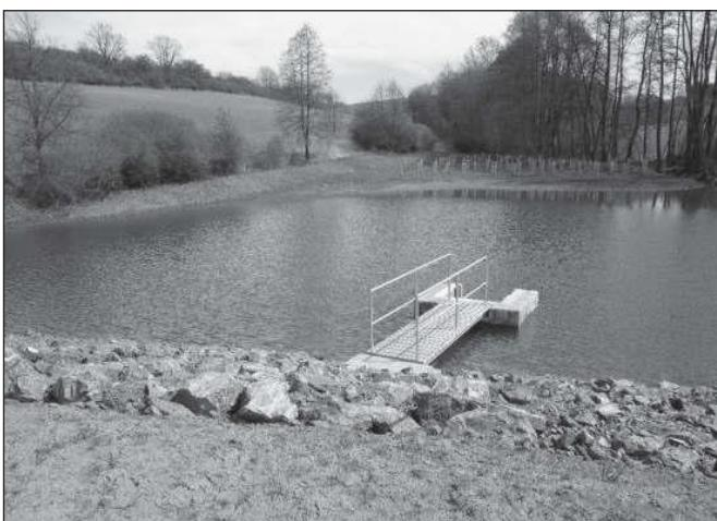
Obr. 12 Návodní líc hráze s kamennou rovnaninou, požerák a v pozadí výsadba dřevin v litorálním pásmu
