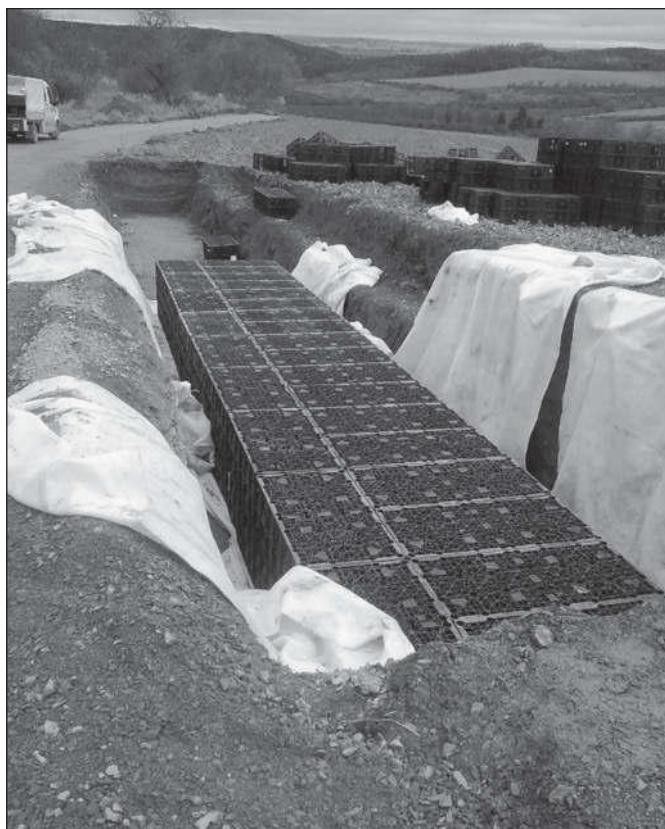
Obr. 8 Vsakovací jáma s galeriemi a fólií před zasypáním
