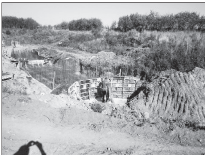
Obr. 9 a 10. Stavba železobetonového výpustního objektu s bezpečnostním přelivem
