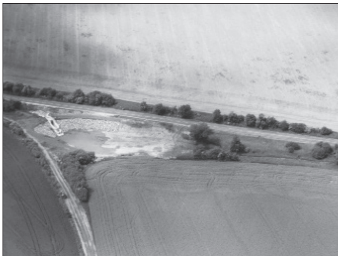
Obr. 11. Retenční nádrž po kolaudaci
