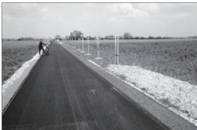
Obr. 4. Střídání stromového patra s keřovým v k.ú. Netřebice
