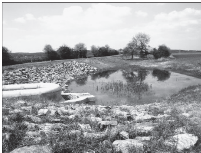
Obr. 12. Stav nádrže v jarních měsících 2016
