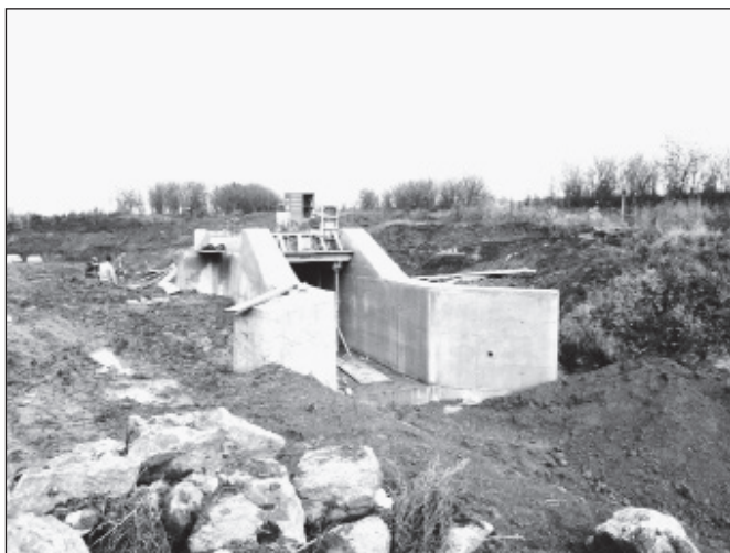
Obr. 9 a 10. Stavba železobetonového výpustního objektu s bezpečnostním přelivem
