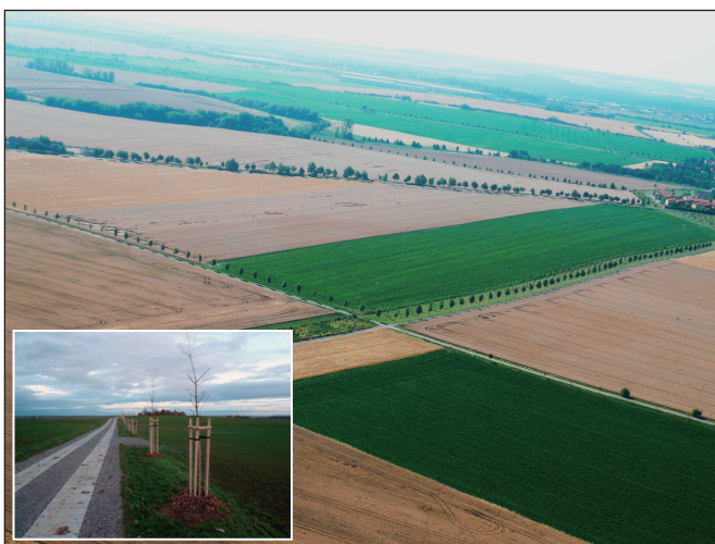
Obr. 28 Výsadby podél dálnice směrem k obci Kanín
