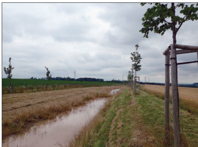
Obrázek 1 Příklad záchytného příkopu (Obec Dubenec, SPÚČR, KPÚ pro Královéhradecký kraj, Pobočka Trutnov)
