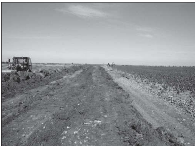
Obr. 7. Rozhrnování horní humusové vrstvy zeminy
