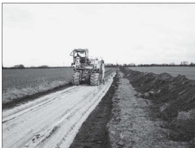
Obr. 2. Úprava zemní pláně vápennou stabilizací
