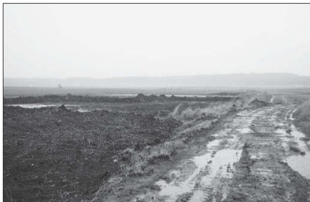
Obr. 2. Foto před výstavbou v roce 2007 – začátek zemních prací na vodní nádrži a polní cesta HC 3
