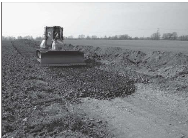
Obr. 6. Pokládání štěrkových vrstev
