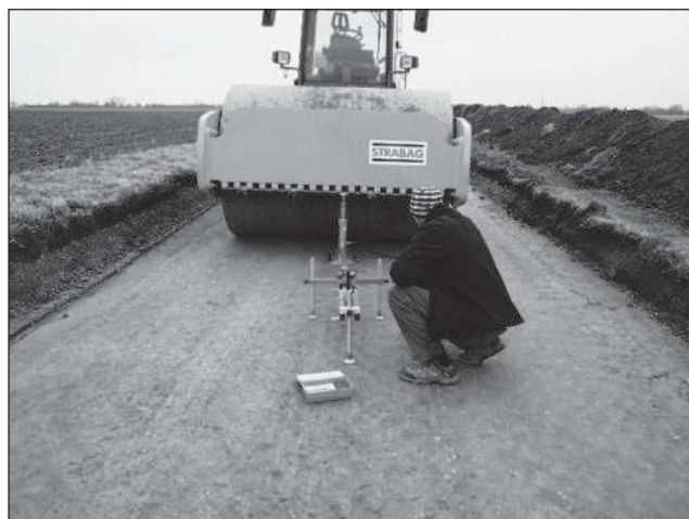
Obr. 3. Zkouška zhutnění pláně
