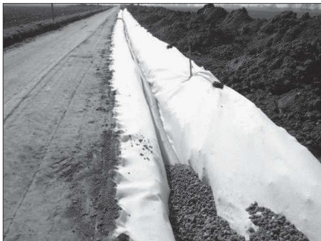
Obr. 4. Odvodnění polní cesty C-2, drenáž DN 160
