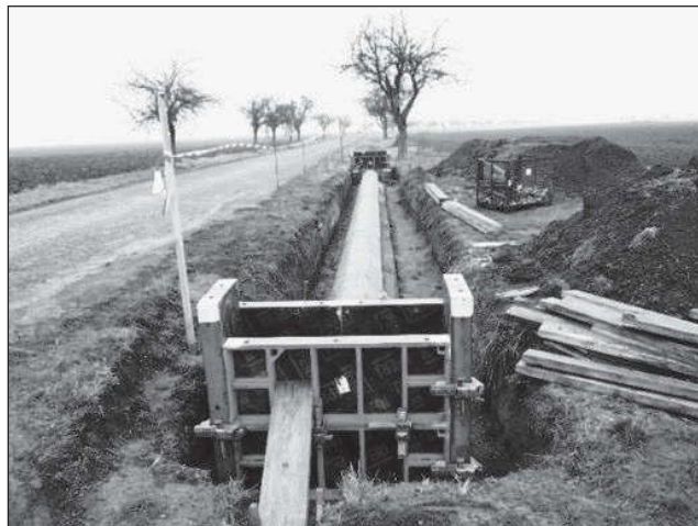
Obr. 1. Napojení PC na silnici III/32924, zatrubnění příkopu
