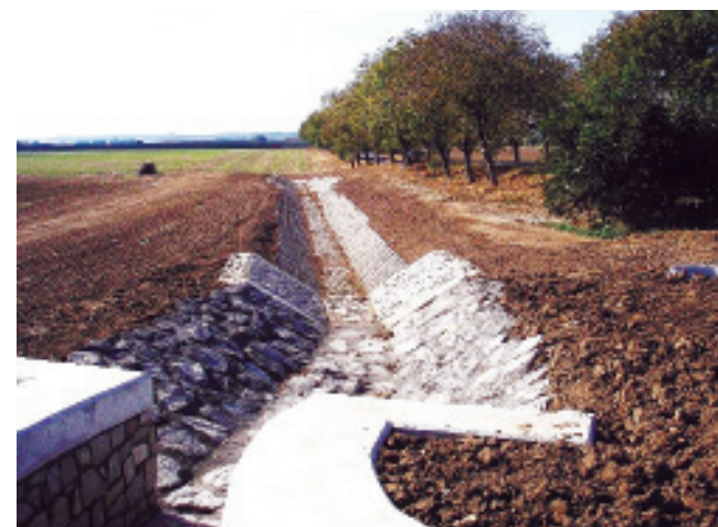
P 1 - Zpevněný začátek obtokového kanálu.
