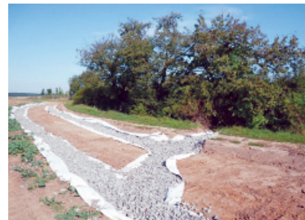
Výstavba hlavní polní cesty C 15 a zaústění drénů do biocentra ŽP 1.
