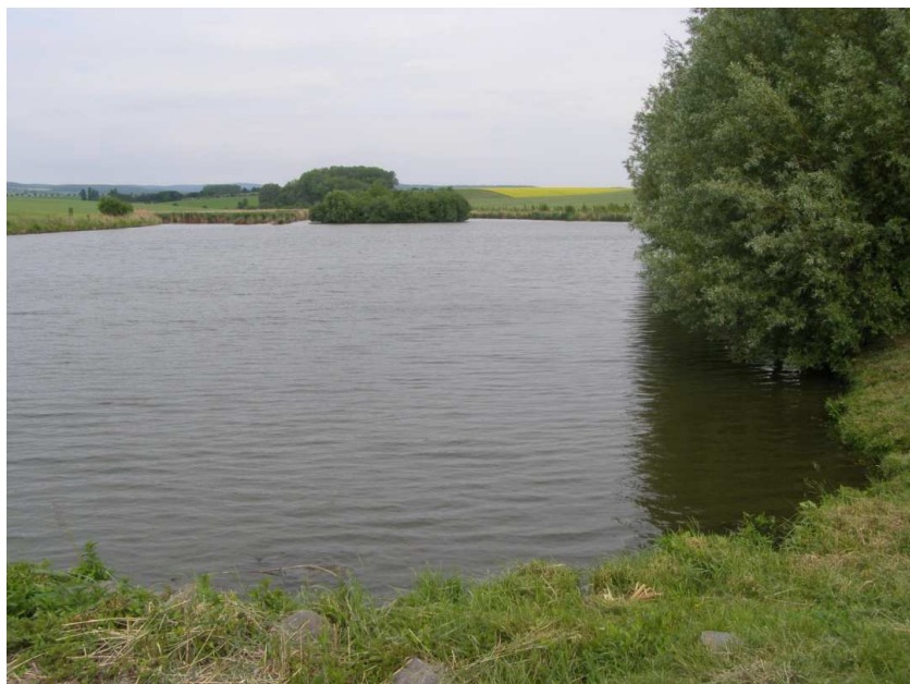
Želeč – vodní nádrž s funkcí biocentra realizovaná v rámci pozemkové úpravy
