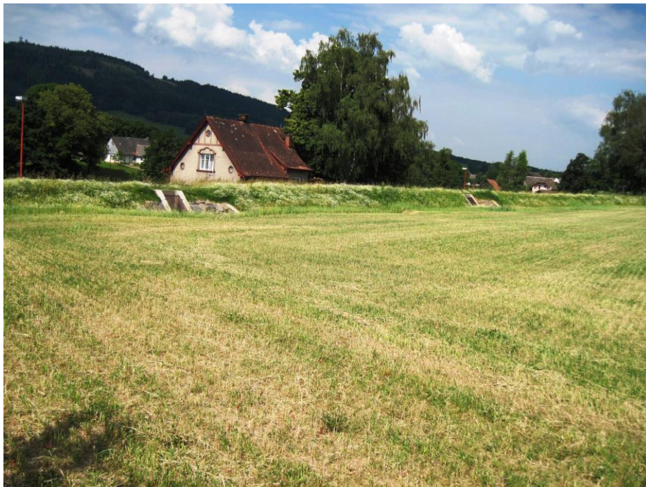
Obr. 10: Ochranná hrázka nad obcí Dolní Brusnice
