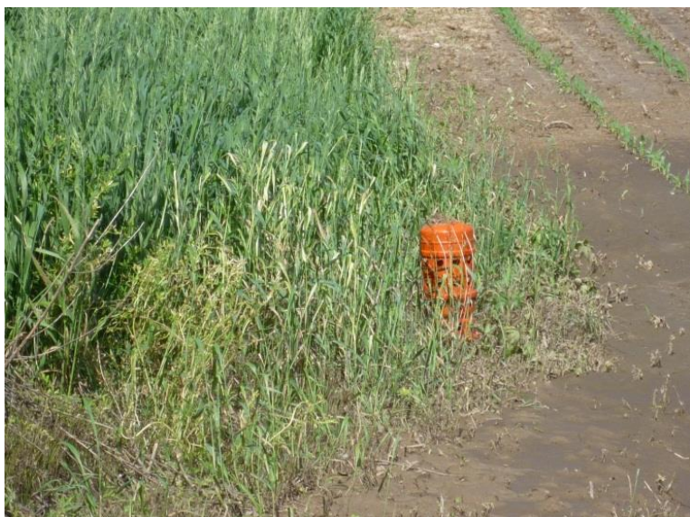
Obr. 31: Vypouštěcí zařízení zemní hrázky
