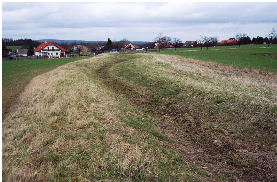
Obr. 5: Protierozní průleh s hrázkou v k. ú. Milínov u Nezvěstic
