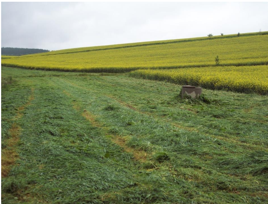
Obr. 6: Příkladem svodného průlehu může být zatravněná údolnice se stabilizací dráhy soustředěného povrchového odtoku – k. ú. Lejškov
