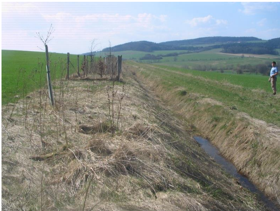
Obr. 7: Protierozní mez se sběrným příkopem v k. ú. Němčice
