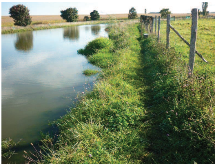
Obrázek 26: Stav po realizaci
