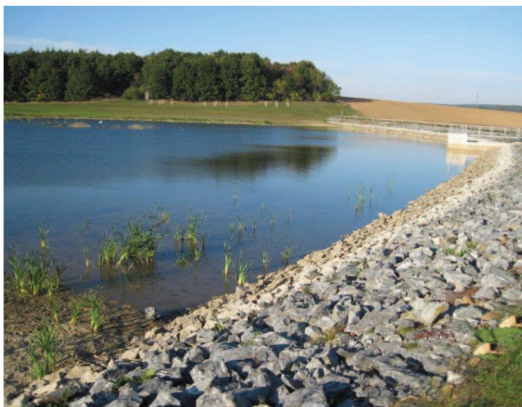
Obrázek 17: Stav po realizaci
