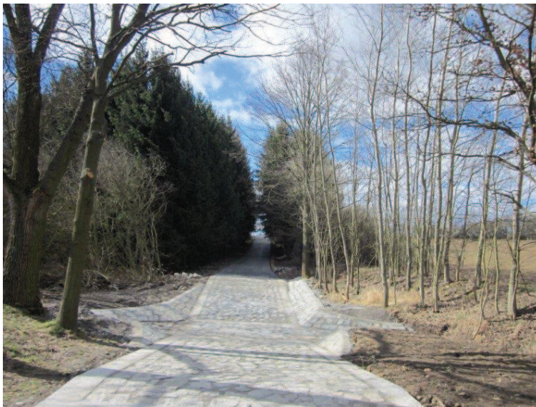
Obrázek 5: Stav po realizaci – bezpečnostní přeliv
