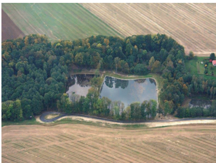
Obrázek 12: Stav po realizaci
