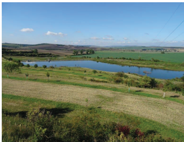
Obrázek 15: Stav po realizaci
