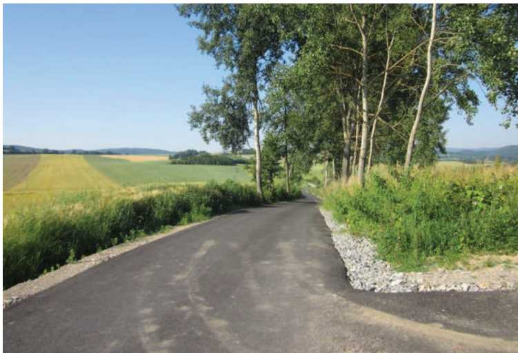
Obrázek 6: Stav po realizaci
