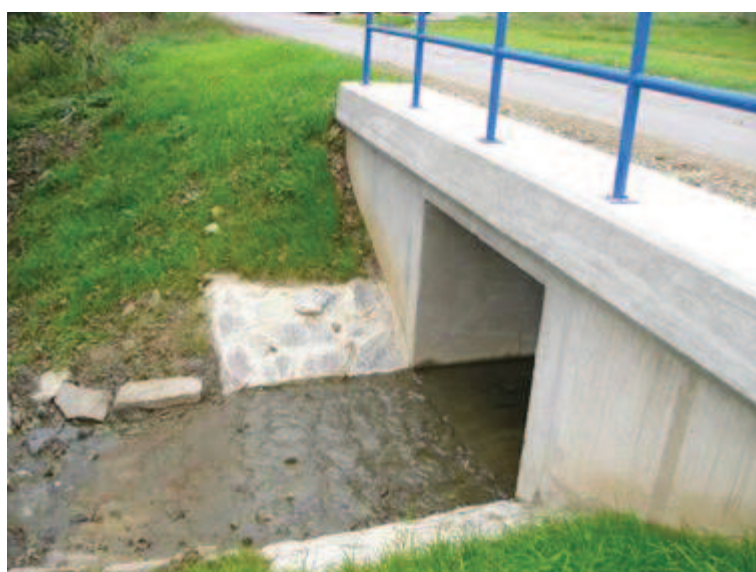
Obrázek 3: Stav po realizaci – oprava mostu
