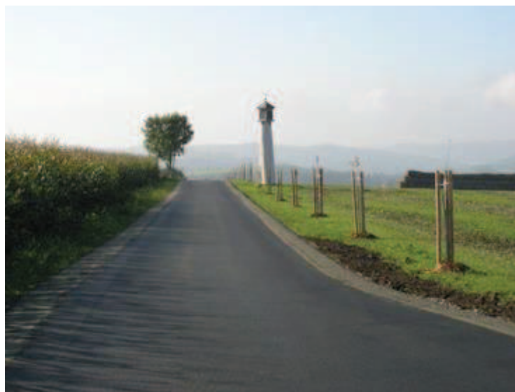
Obrázek 2: Stav po realizaci
