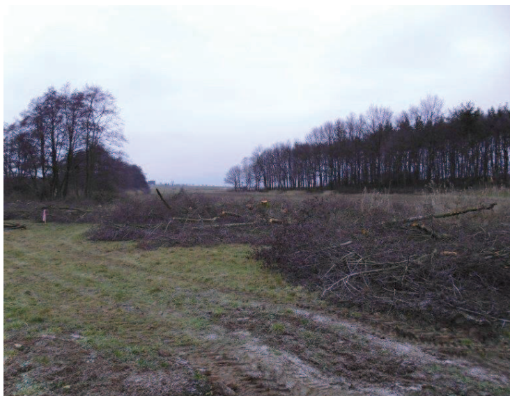
Obrázek 16: Stav před realizací
