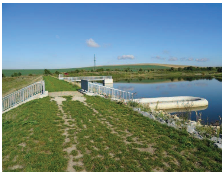
Obrázek 14: Stav po realizaci
