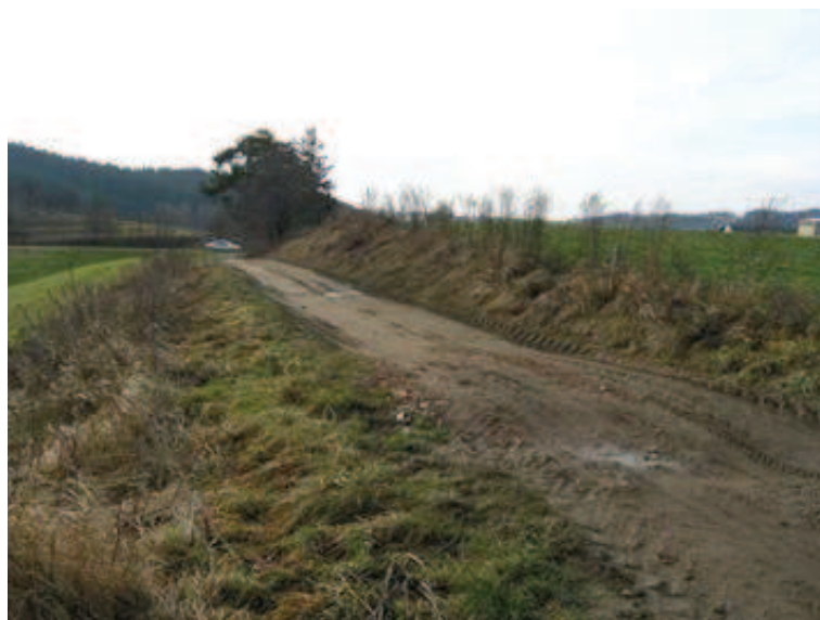
Obrázek 1: Stav před realizací
