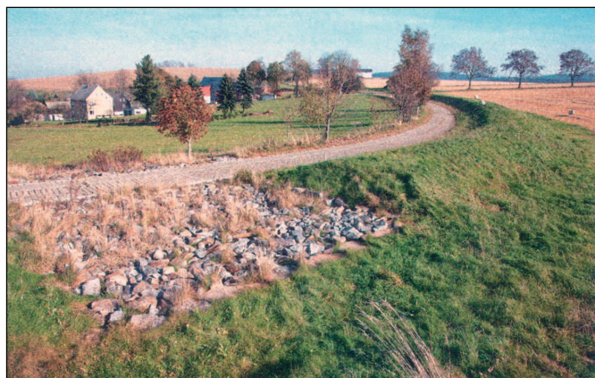
Obr. 9 Vybudovaná hráz s hospod. cestou Marktsteig, povodí A1
