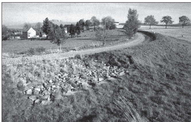
Obr. 9 Vybudovaná hráz s hospodářskou cestou Marktsteig, povodí A1
