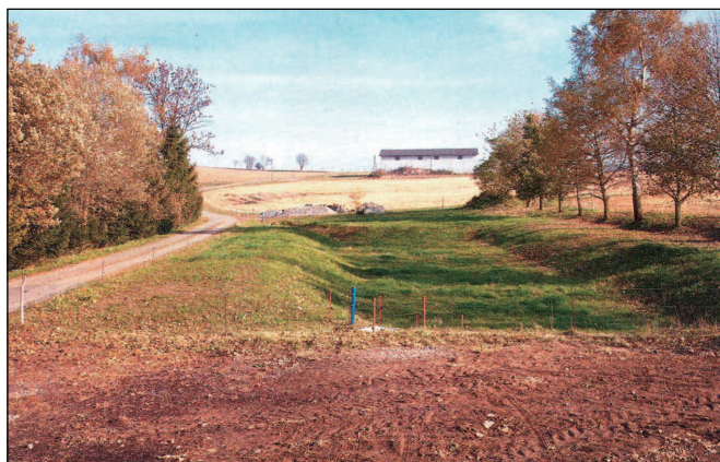
Obr. 10 Vybudovaná retenční nádrž, povodí A2
