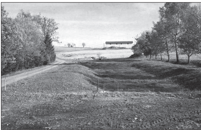
Obr. 10 Vybudovaná retenční nádrž, povodí A2
